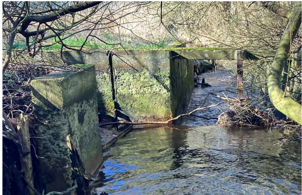
Figur 4: Den nu nedlagte opstemning til dambruget.
